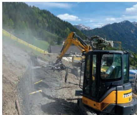
Unten: Nagelwände mit Spritzbeton
