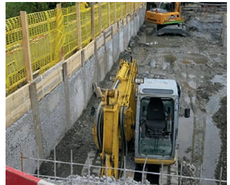
Rechts: Stahlträger vibriert, Ausfachung mit Sickerbeton
