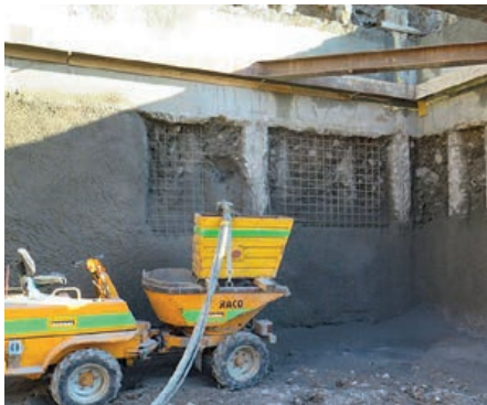
Links: Ortbetonbohrpfähle mit Spritzbetonausfachung
