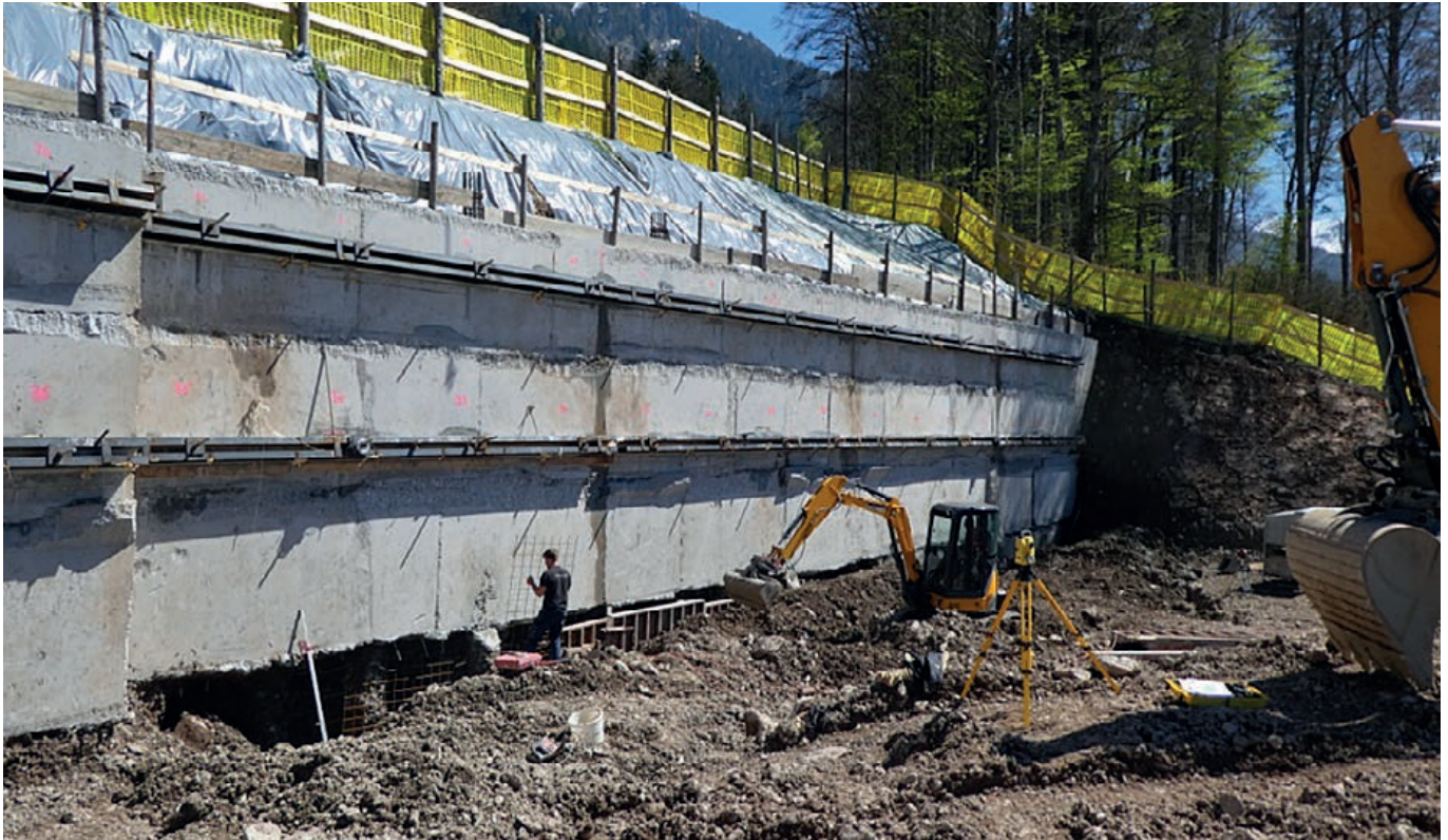
Rückverankerte Rühlwand, mit Bohrpfählen und etappenweiser Ortbetonausfachung
