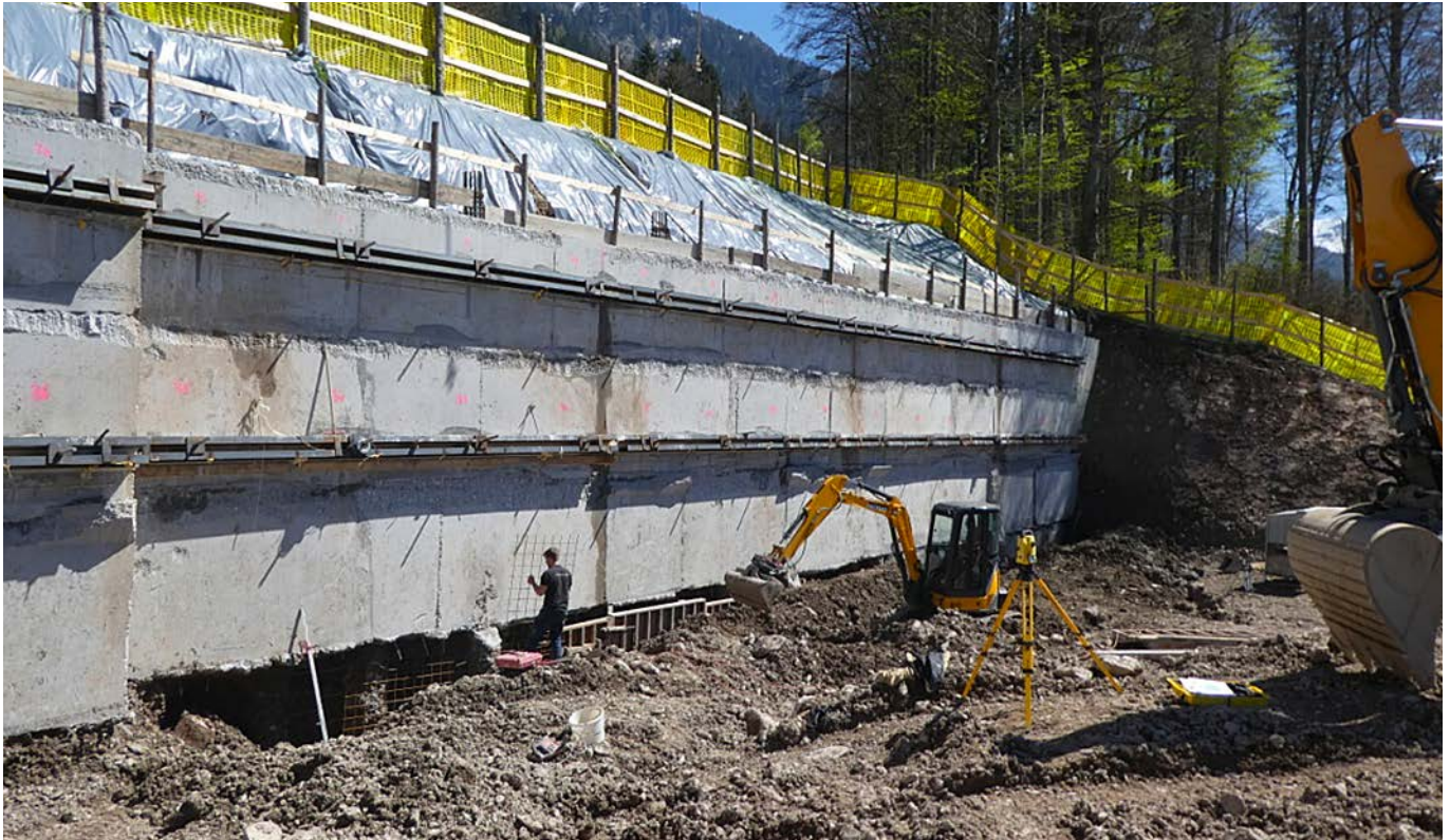
Rückverankerte Rühlwand, mit Bohrpfählen und etappenweiser Ortbetonausfächung
