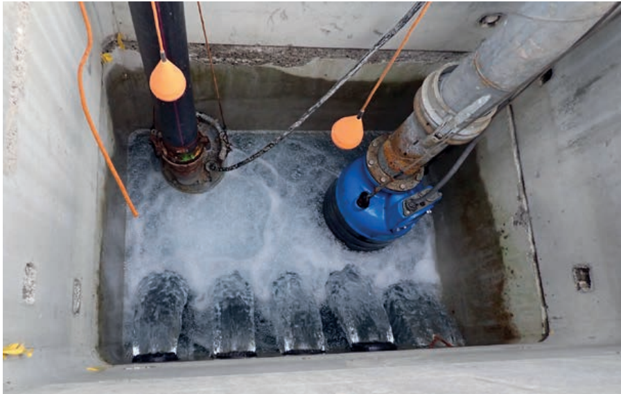
Vorfabrizierte Pumpenschächte für offene Wasserhaltungen
