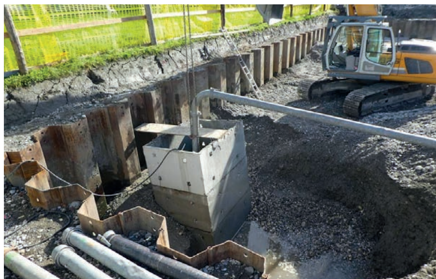
Vorfabrizierte Pumpenschächte für offene Wasserhaltungen
