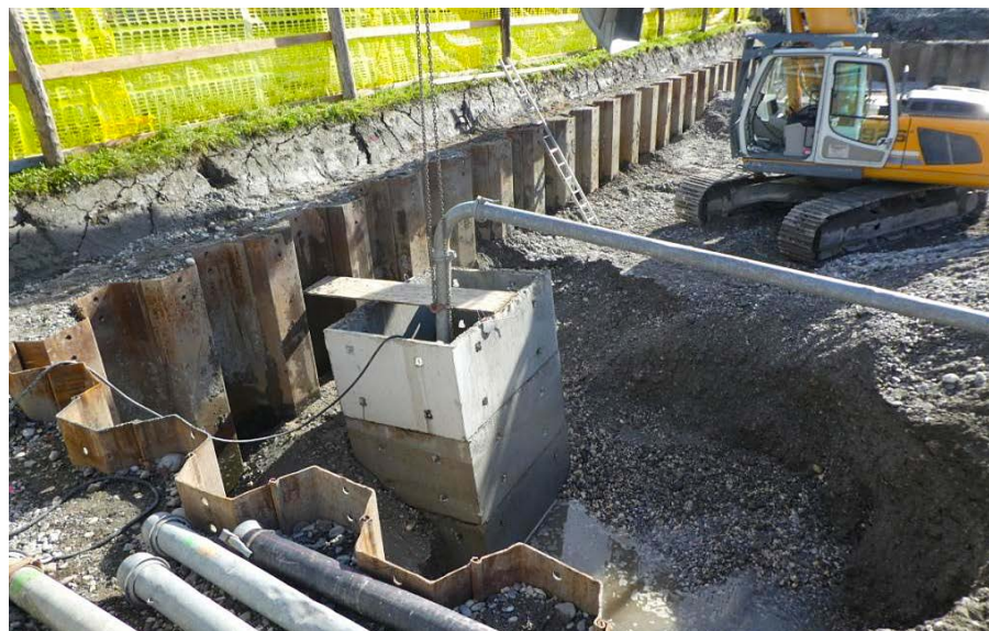
Vorfabrizierte Pumpenschächte für offene Wasserhaltungen
