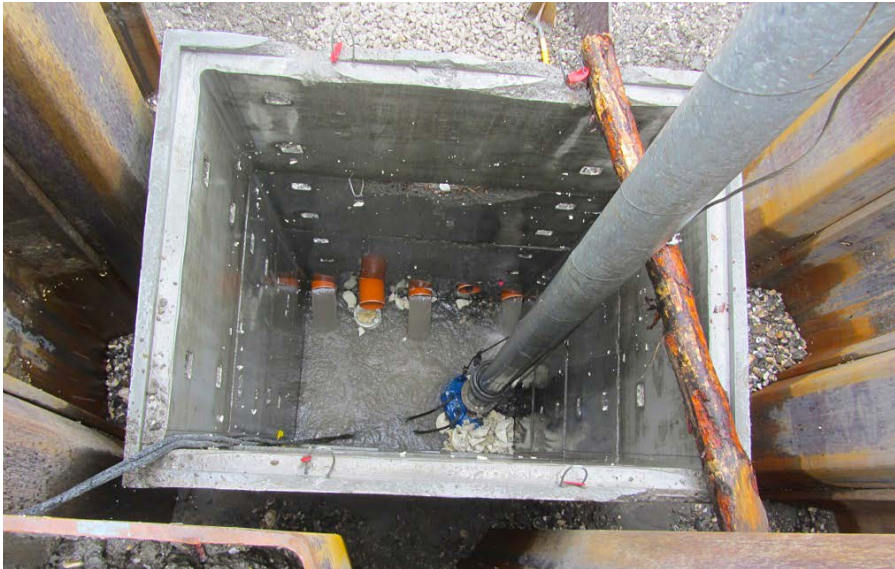
Vorfabrizierte Pumpenschächte für offene Wasserhaltungen
